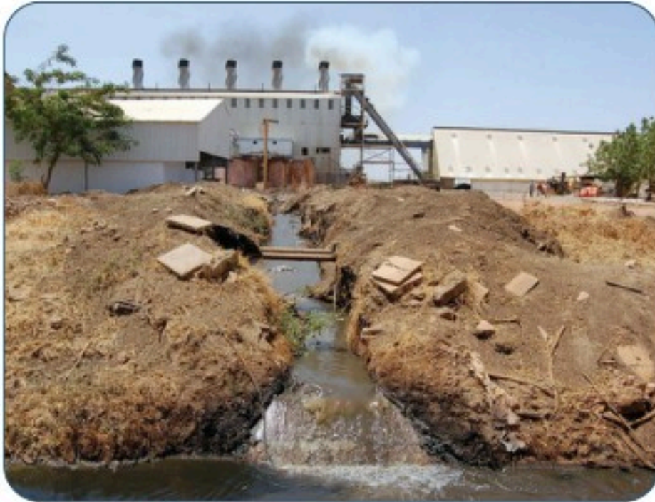
شكل 20-8 مخلفات الصرف الصناعي
