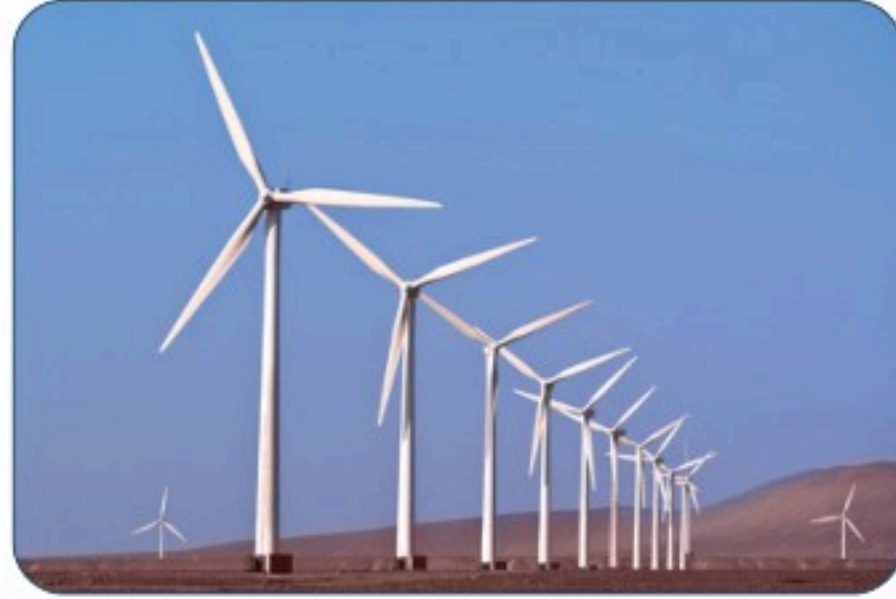
شكل 7-19 توليد الكهرباء باستخدام طاقة الرياح
