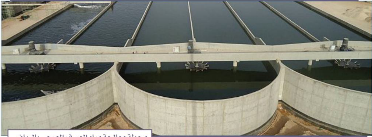
محطة معالجة مياه الصرف الصحي بالرياض
