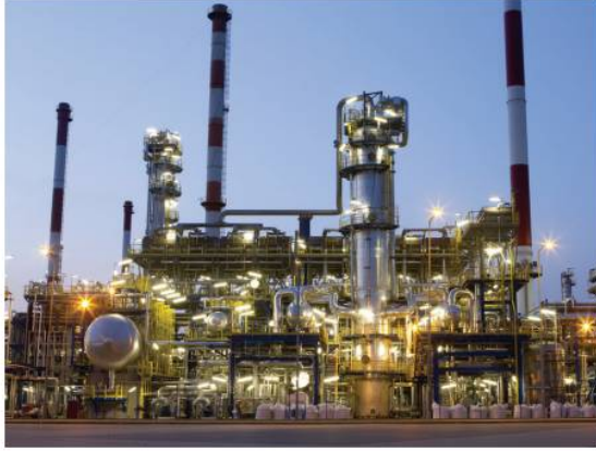
محطة توليد الكهرباء في الجبيل
