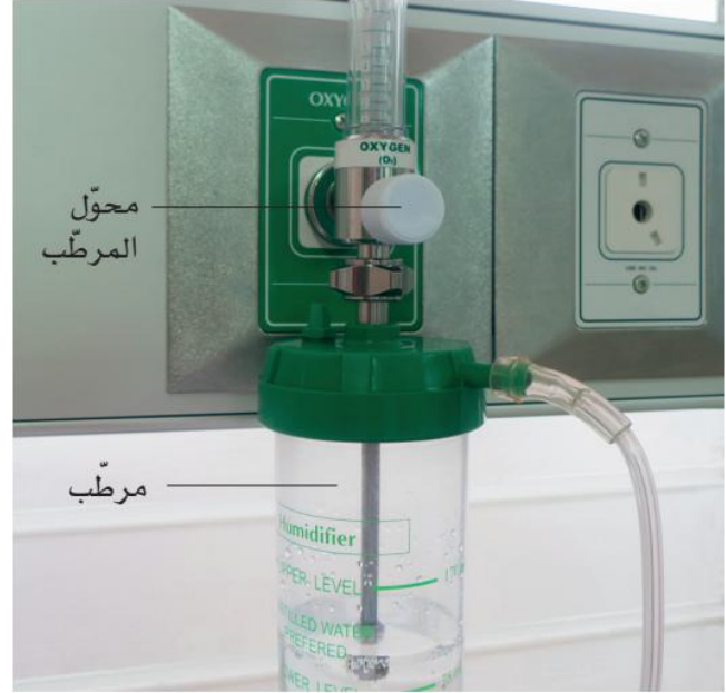
الشكل "57-3 أ" عندما يُضخ الأكسجين عبر الحائط، يوصل مقياس التدفق بمحلول المرطب لتزويد الأكسجين.
