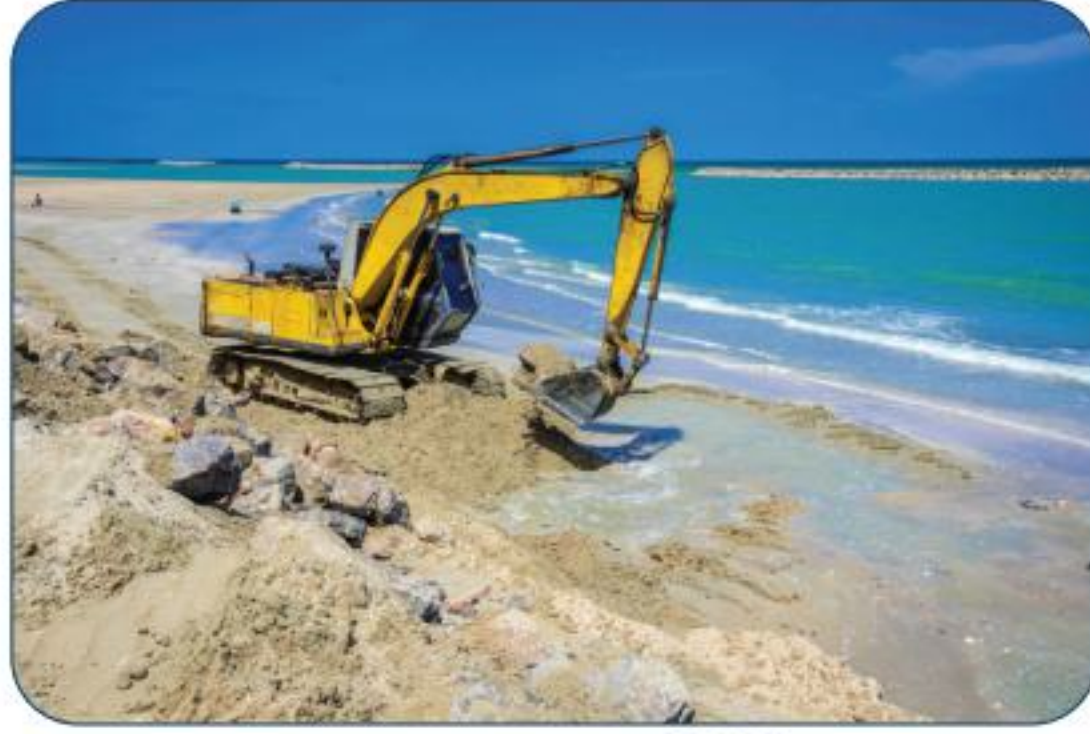
شكل 24-8 تجريف مياه البحر.
