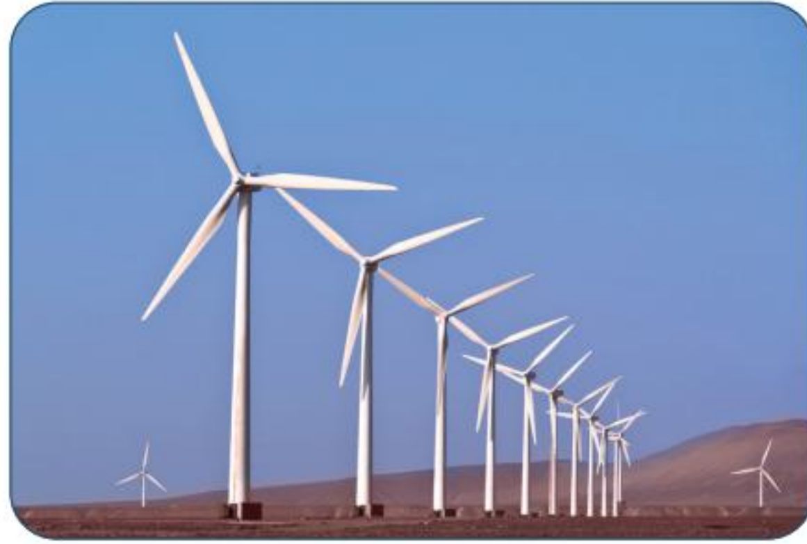
شكل 7-19 توليد الكهرباء باستخدام طاقة الرياح
