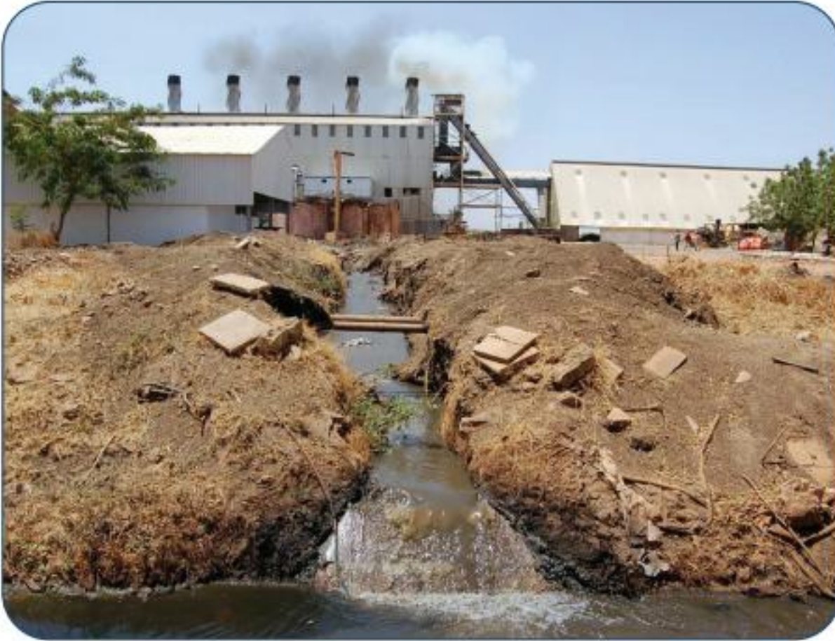
شكل 20-8 مخلفات الصرف الصناعي
