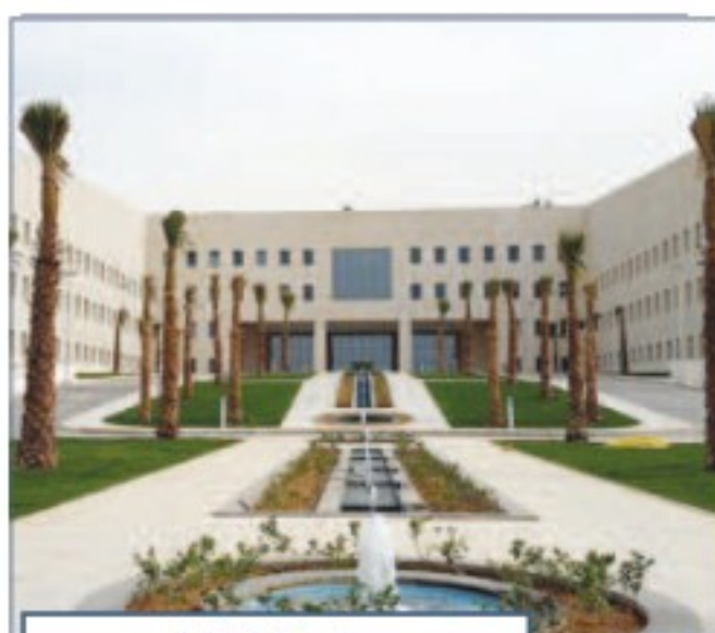
مبنى وزارة التعليم
